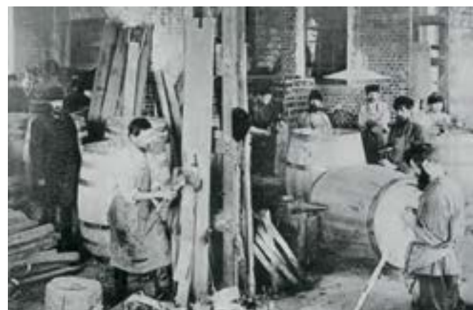
Жигулевский пивзавод, производство бочек. Фото, начало XX века
