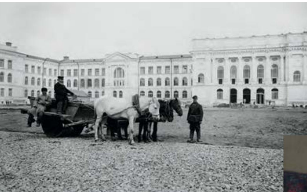
Укладка покрытия во дворе Политехнического института в Санкт-Петербурге. Фото, конец XIX века
