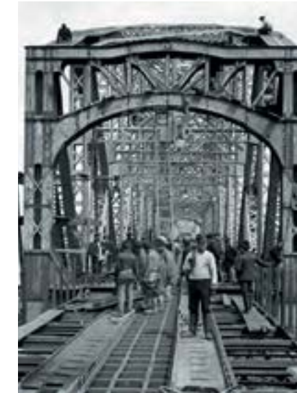
Строительство Романовского моста на станции Нижние Вязовые. Фото, конец XIX века
