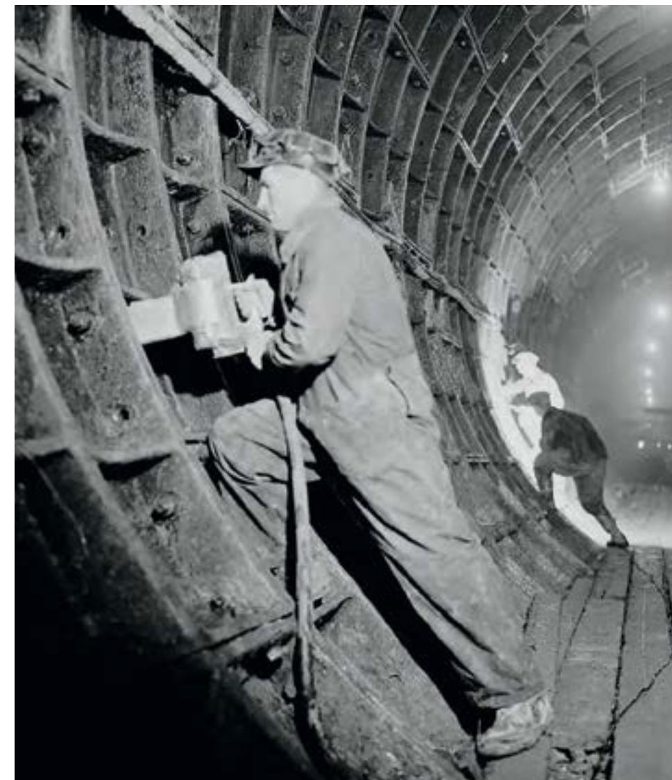
Строительство московского метро. 1930-е годы
