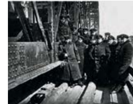
Западно-Сибирская железная дорога. Мост через реку Обь. Испытание прогиба прибором Френкеля, 1892 год
