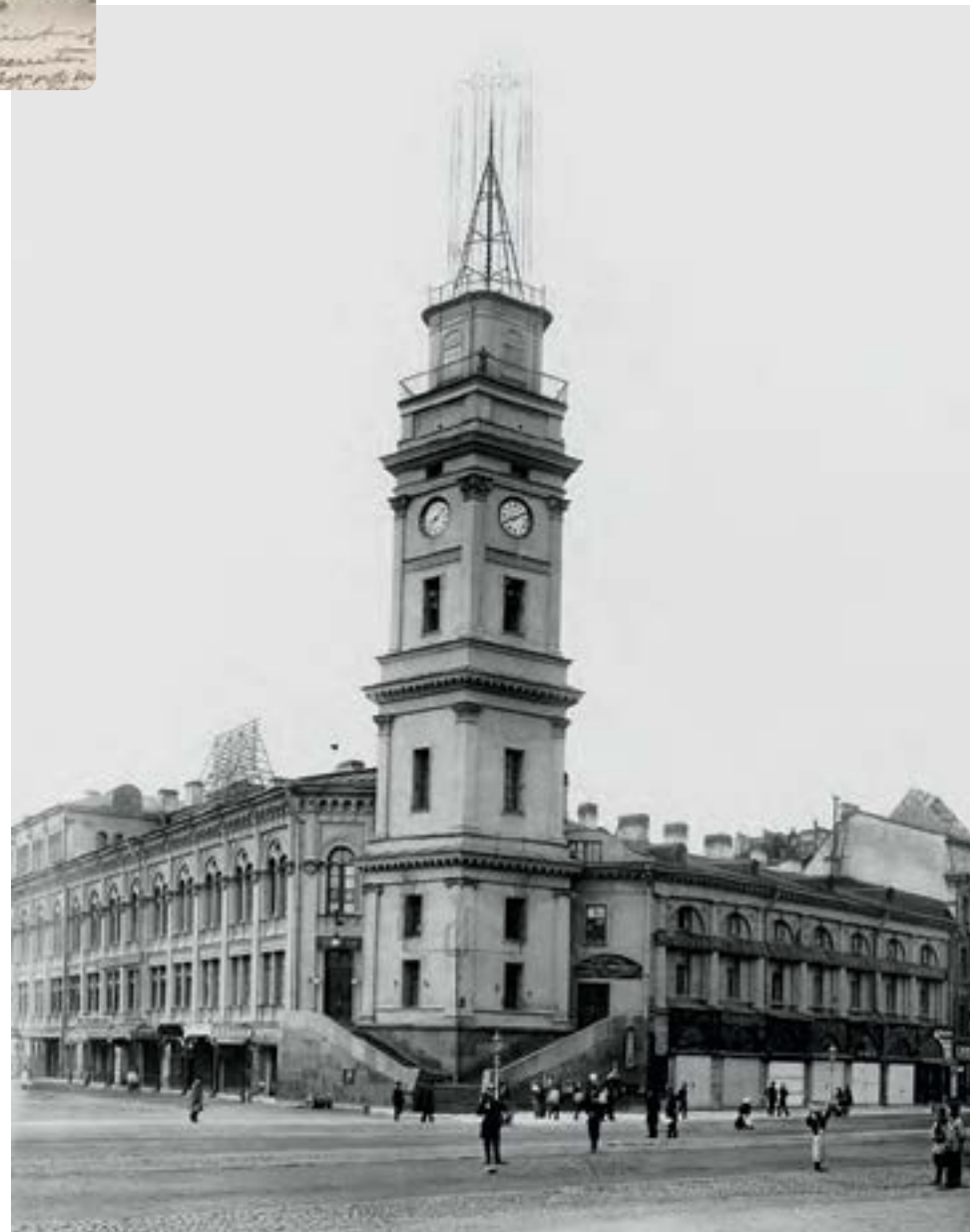
Здание Санкт-Петербургской городской думы. На башне конструкция оптического телеграфа, использовался до 1954 года
