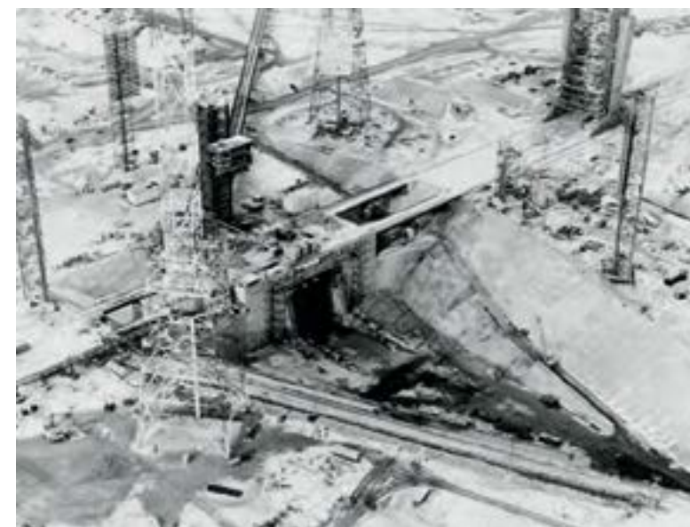
Панорама строительства универсального комплекса стэнд-старт на Байконуре. 1960-е годы
