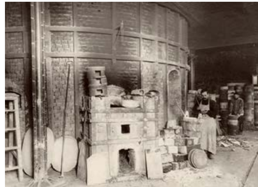
Императорский фарфоровый завод. Печь для обжига фарфора. Фото, начало XX века
